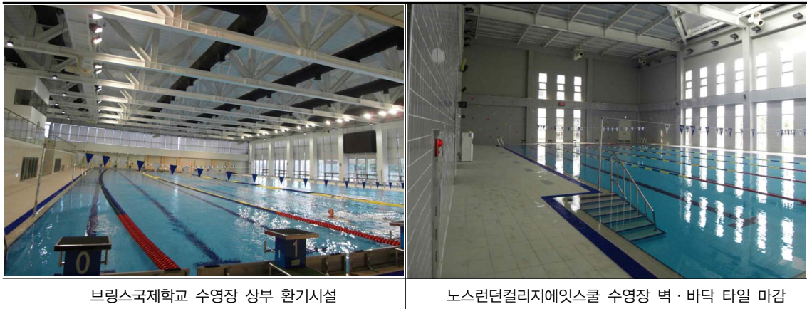
그림4-55. 수영장 환기설비 및 마감
