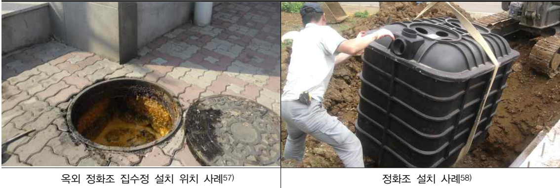
그림4-116. 정화조 위치 및 설치
