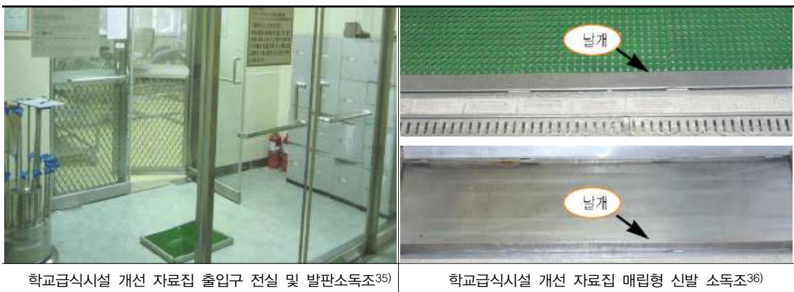
그림4-59. 조리실 출입구 소독조 및 수세시설
