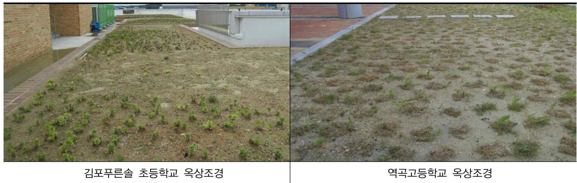
그림4-123. 교내 옥상조경 시공 사례
