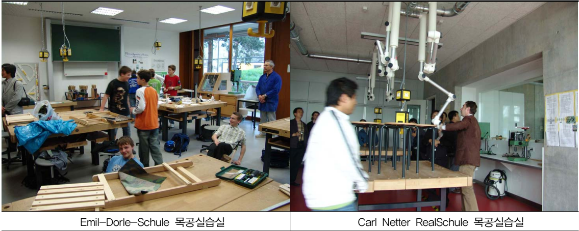
그림4-35. 실습실 내에 벽면 및 천장형으로 시공된 콘센트
