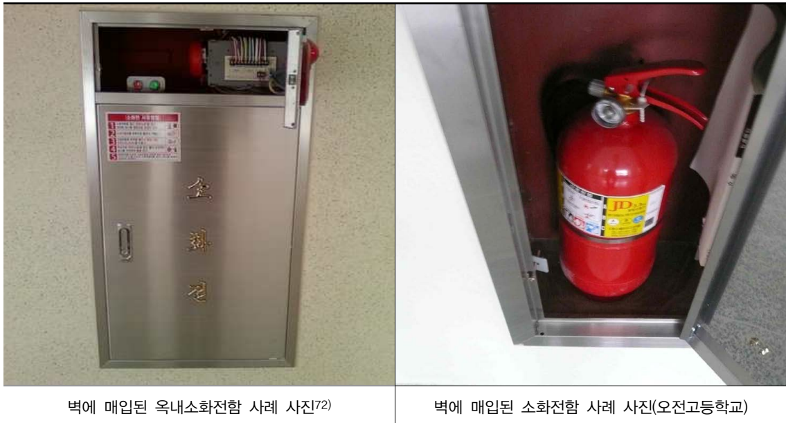
그림4-130. 옥내소화전 및 소화기함 매입 사례
